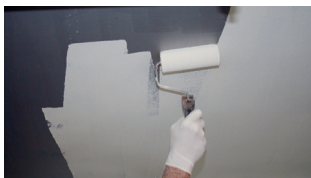
Apply antifouling over primer or tiecoat
